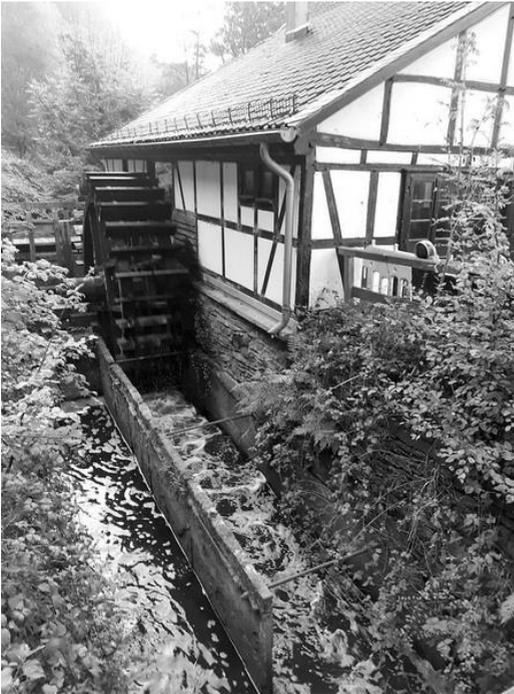
Das Wasser der Wupper wurde durch einen Graben zu dem Schleiferkotten umgeleitet. Es trieb ein riesiges Wasserrad unterschlächting an, welches seinerseits der Hauptantrieb für alle anderen Schleif- und Poliersteine war. Danach wurde das Wasser durch die Fortführung des Grabens der Wupper wieder zugeführt. Der Kotten stand also auf einer Insel.
